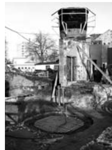
Fot. 4 i 5. Pozostałości szybu Wilhelmina o średnicy 2,7 metra w obudowie murowej ceglanej. Fot. Jan Woźniak, listopad 2011 r.
