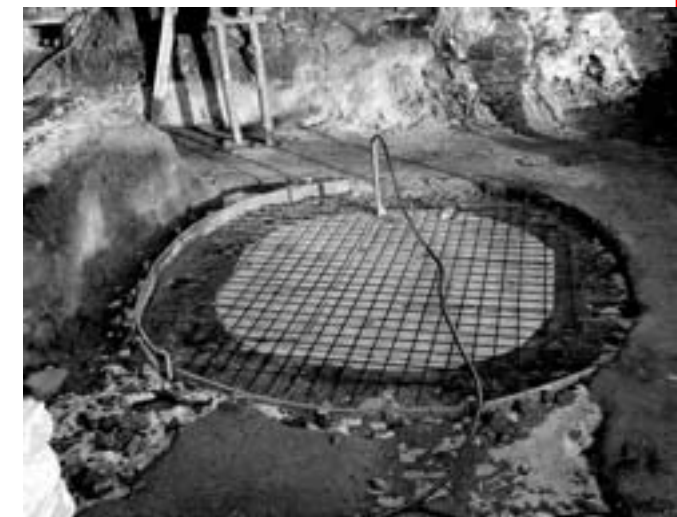
Fot. 4 i 5. Pozostałości szybu Wilhelmina o średnicy 2,7 metra w obudowie murowej ceglanej. Fot. Jan Woźniak, listopad 2011 r.
