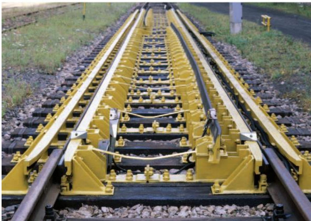
Rys. 5. Torowe stanowisko przestawcze systemu SUW 2000 [24].
