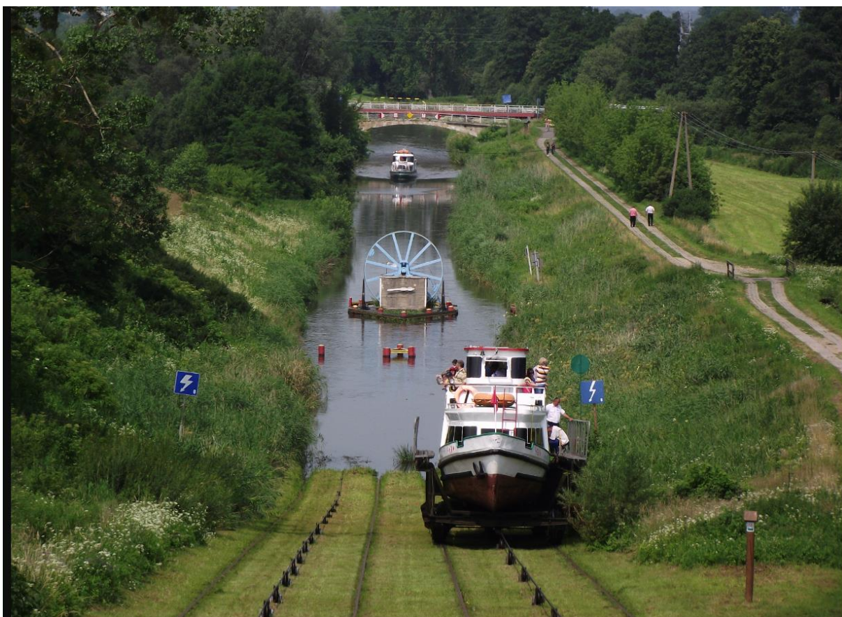
Rys. 2. Pochylnia na Kanale Elbląskim. Unikalna konstrukcja, przy której transport statków na pochylni odbywa się dzięki wodzie [11].
