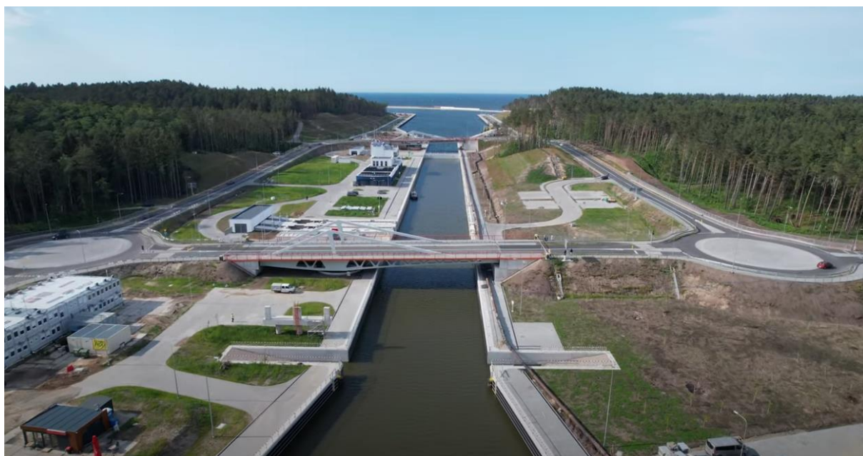
Rys. 8. Przekop Mierzei Wiślanej po otwarciu drogi wodnej w dniu 10.06.2022. Widoczne oba mosty obrotowe. Most południowy otwarty dla ruchu samochodowego. Za tym mostem śluza i kapitanat portu Nowy Świat. W dali port osłonowy na Zatoce Gdańskiej [27].
