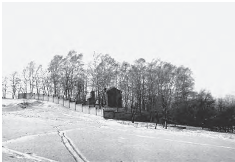
Fot. 7. Widok z lat 70. na pozostałości po zabudowaniach dawnego Obserwatorium Magnetycznego w Mikołowie
