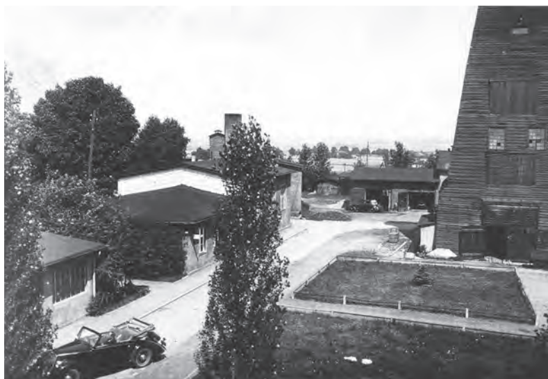
Fot. 4. Fragment wieży szybowej kopalni Barbara w Mikołowie, widok z końca lat 20. XX wieku
