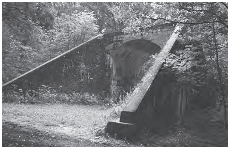
Rys. 2. Pozostawiony w lesie wiadukt kolejowy po niedokończonej bocznicy kolejowej
