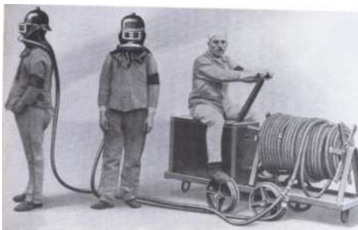
Rys.3. Aparat węzowy Koenig w roku 1910 (zdjęcie - Sala Tradycji OSRG Jaworzno)
