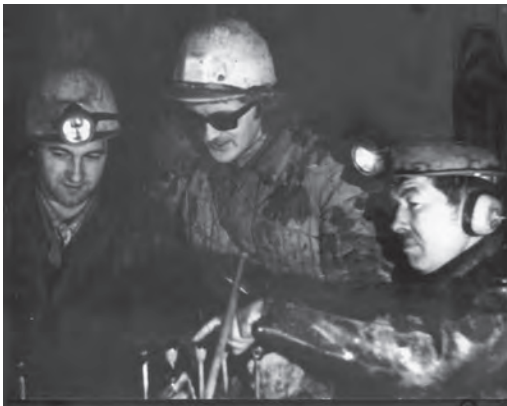
Fot. 9. Przodowy (z prawej) wtajemnicza studentów w pracę wiertniczą w przodku sztolni wodnej „Burkersdorf” (lato 1976)
