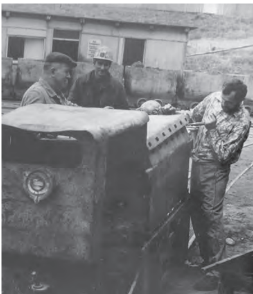
Fot. 10. Student (z prawej) ściśle wykonuje polecenia mechaników w warsztacie na placu budowy sztolni wodnej „Burkersdorf” (lato 1977)
