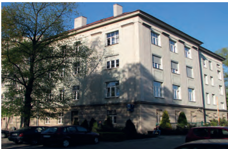
Fot. 6. Budynek dawnej bursy studenckiej na ul. Gramatyka – stan obecny (fot. B. Barchański)
