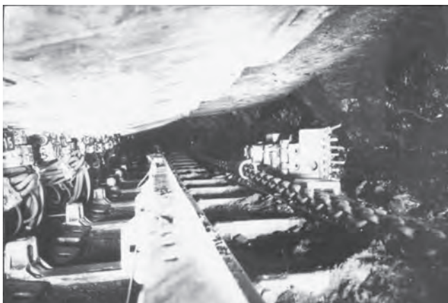
Fot. 37. Urabianie cienkich pokładów antracytu strugami w kop. „Preussag” „bez udziału” załogi
