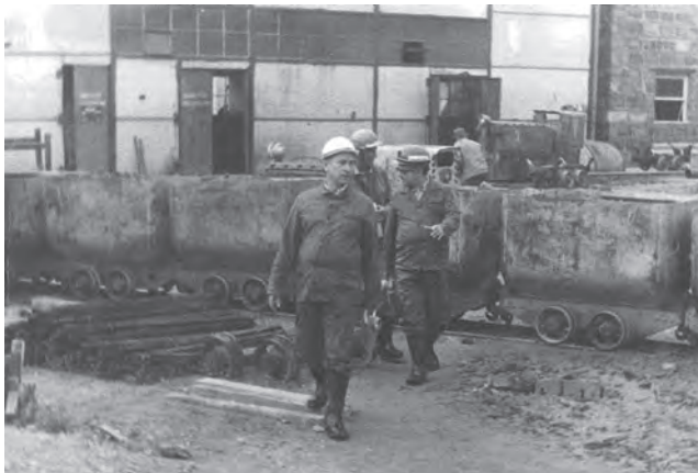
Fot. 22. Życzliwi Studenckiemu Kołu SITG AGH Kierownik Budowy Burkersdorf-Eibenstock dyr. mgr inż. Z. Zając (pierwszy z lewej) i Pełnomocnik „Kopexu” dyr. mgr inż. J. Raszka (drugi z lewej) po „objeździe” stanowisk pracy w sztolni wodnej „Burkersdorf” (lato 1977)
